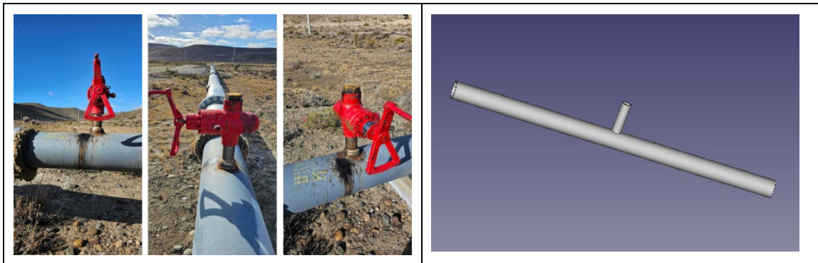
Figura 5: Modelo de inserção hot-tap.
